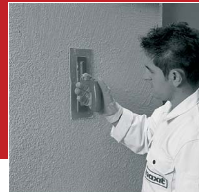
4. Verreiben des Oberputzes
