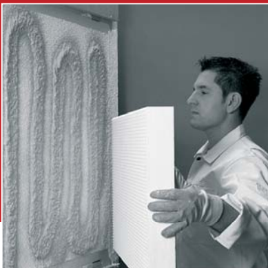
1. Aufbringen der Dämmplatten
