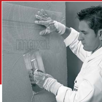
2. Armierungsschicht inkl. Gewebe
